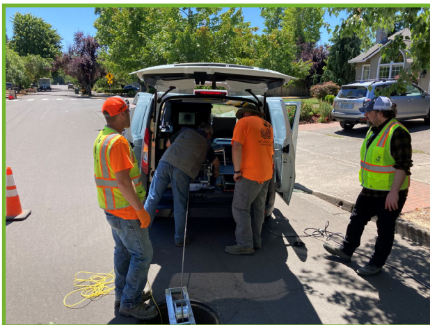
The new CCTV van
